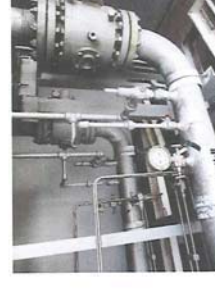
รูปอุปกรณ์ควบคุมความดันก๊าซเชิงกักเก็บกักเก็บแบบระบาย
