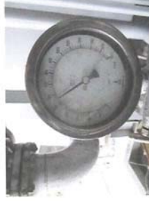
รูปมาตรวัดแรงดันก่อนเข้าอุปกรณ์ปรับลดแรงดัน
